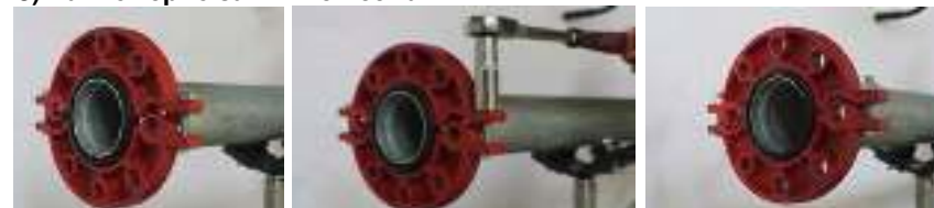
Рис. 1. Монтаж накидного разъемного фланца «LEDE».
